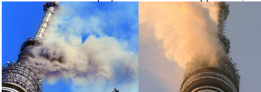
Рис. 8 Пожар на телебашне
