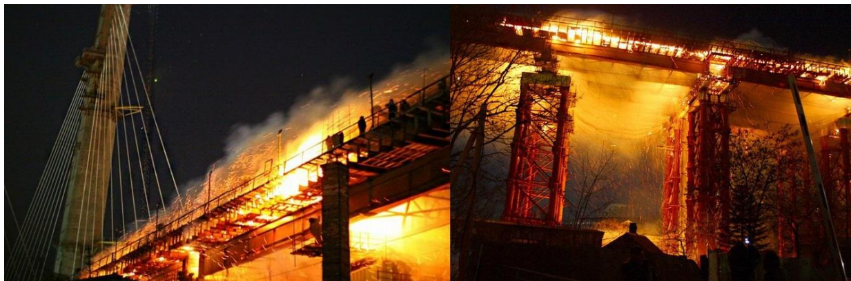
Рис. 6 Пожар на мосту
