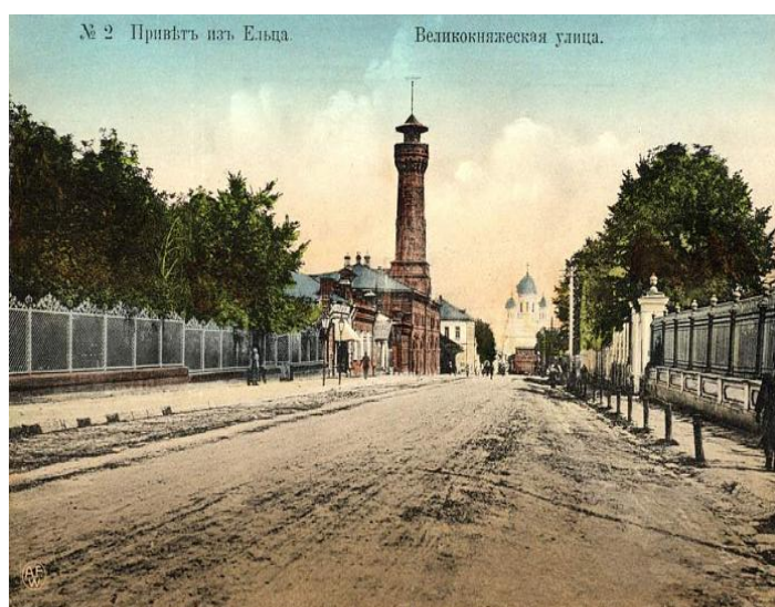
Рис. 9. Фотография 2-й Пожарной части после перестройки.
